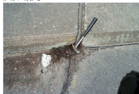
BETONAUSPATZUNG
